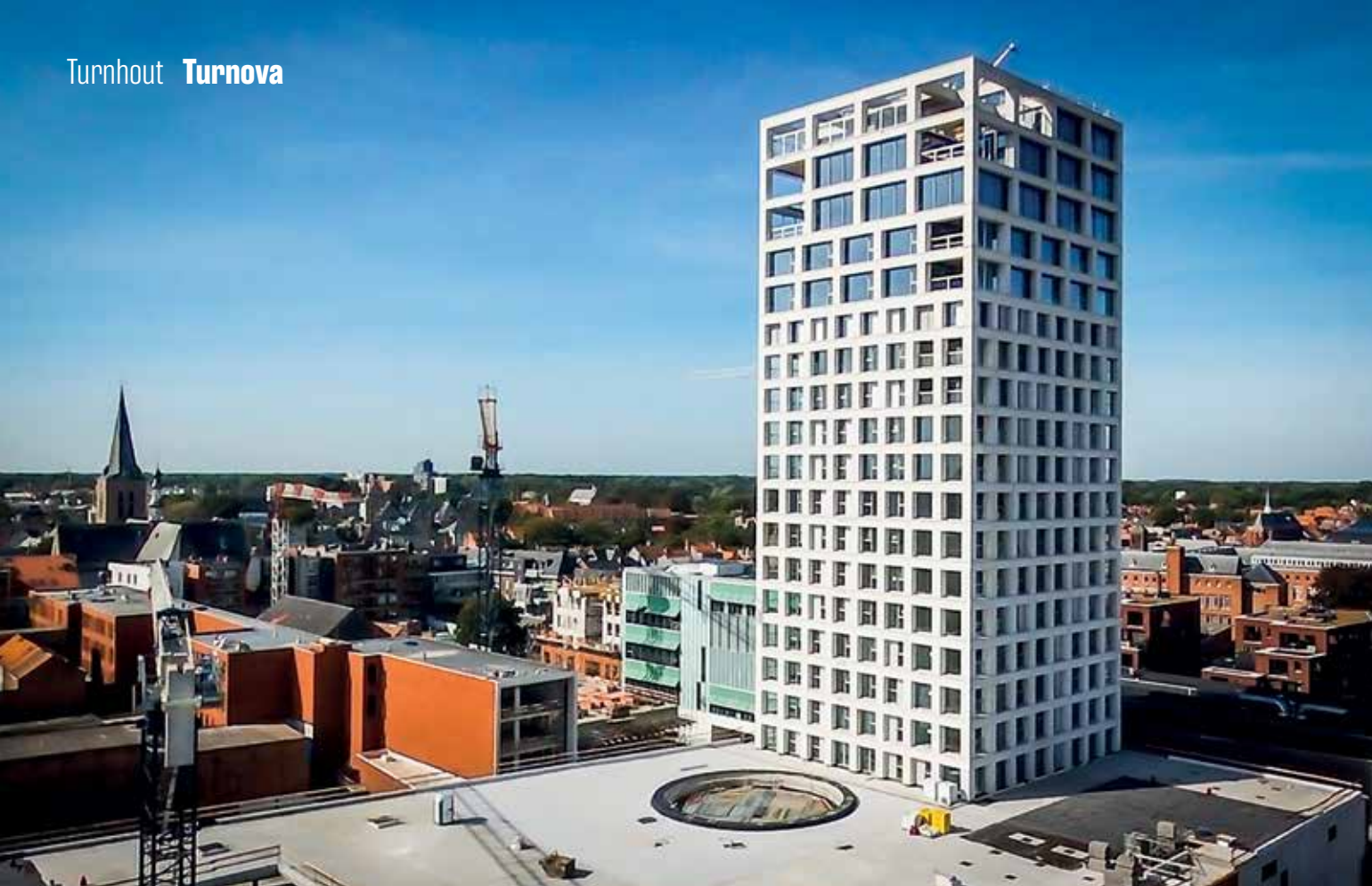
De gevels van de Turnova-toren bestaan volledig uit wit gezuurd architectonisch beton. Een hedendaagse verwijzing naar de witte natuursteen van het stadhuis aan de Grote Markt.
