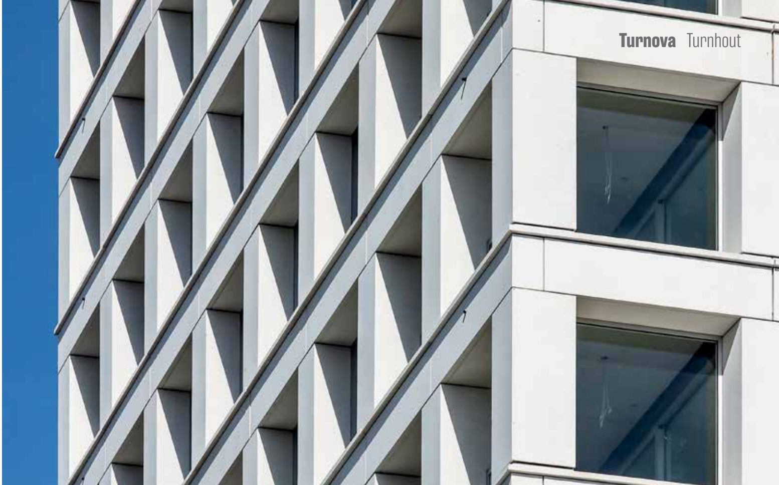
De gevels van de Turnova-toren zijn opgevat als een sandwichstelsel: een dragende kern in constructief beton met daarrond isolatie en een U-vormige buitenschil. Structuur en esthetiek in één!
